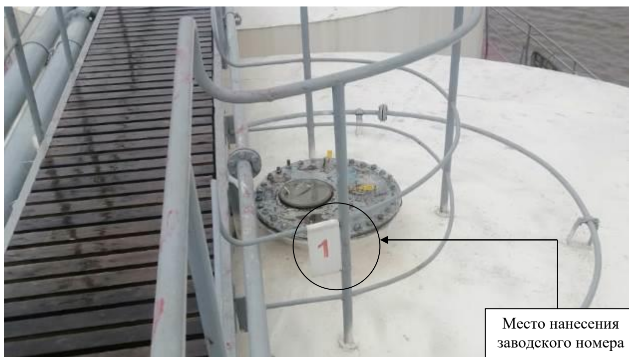
Р и с у н о к 3 – Общий вид замерного люка и место нанесения заводского номера
