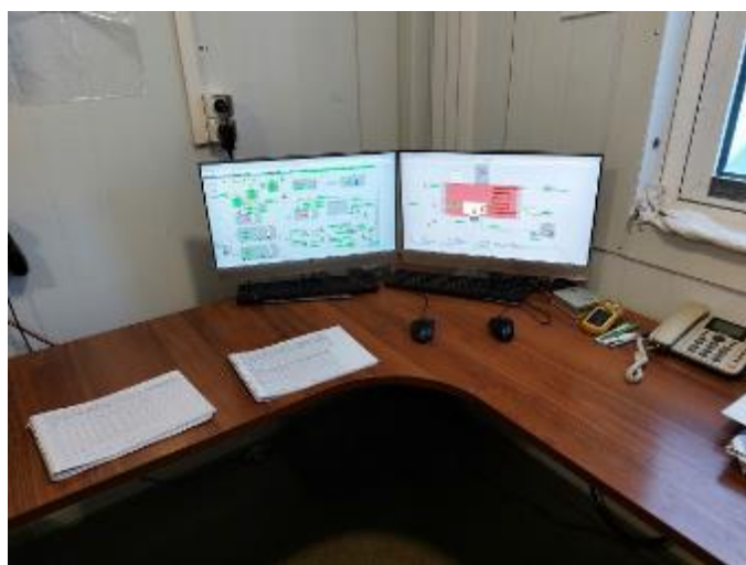
Рисунок 3 – Основная и резервная рабочие станции оператора
