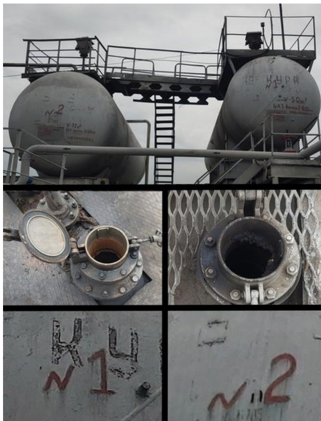
Рисунок 1 – Фотография общего вида резервуаров РГС-73 (№2), РГС-50 (№1), горловин и заводских номеров
