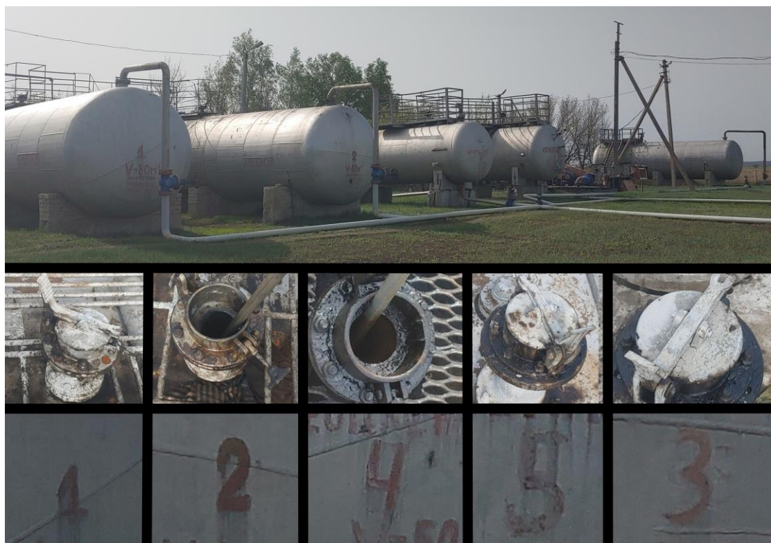
Рисунок 1 – Фотография общего вида резервуаров РГС-80 (№1, 2, 3), РГС-50 (№4), РГС-25 (№5), горловин и заводских номеров
