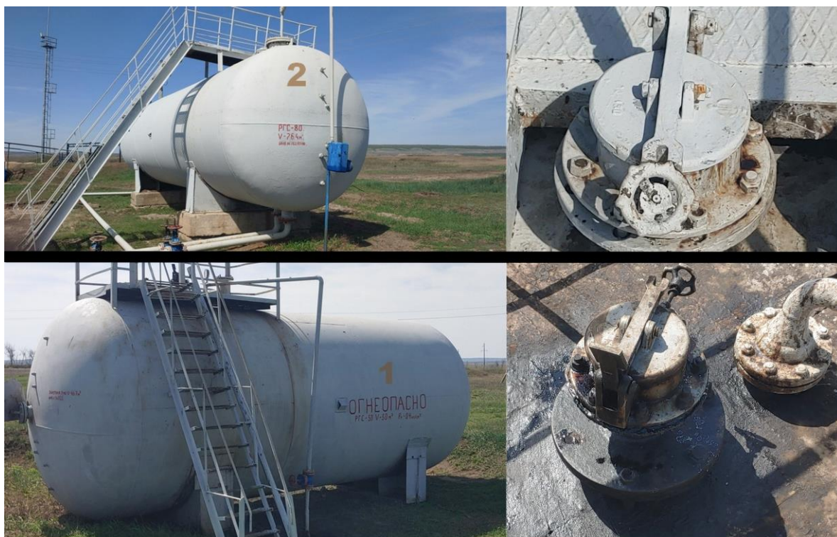
Рисунок 1 – Фотография общего вида резервуаров РГС-80 (№2), РГС-50 (№1), горловин и заводских номеров
