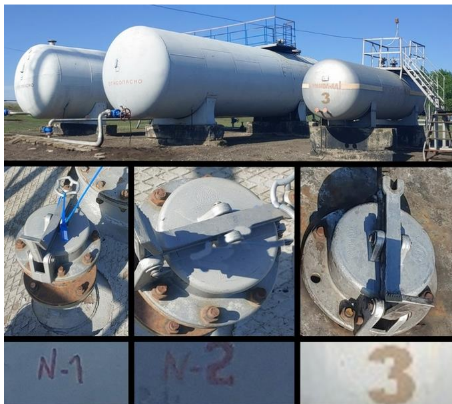
Рисунок 1 – Фотография общего вида резервуаров РГС-80 (№2), РГС-77 (№1), РГС-15 (№3) горловин и заводских номеров
