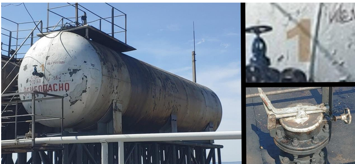
Рисунок 1 – Фотография общего вида резервуара РГС-55 (№1) горловины и заводского номера
