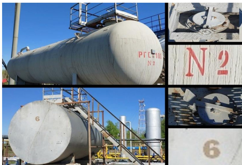
Рисунок 1 – Фотография общего вида резервуаров РГС-100 (№2), РГС-25 (№6), горловин и заводских номеров
