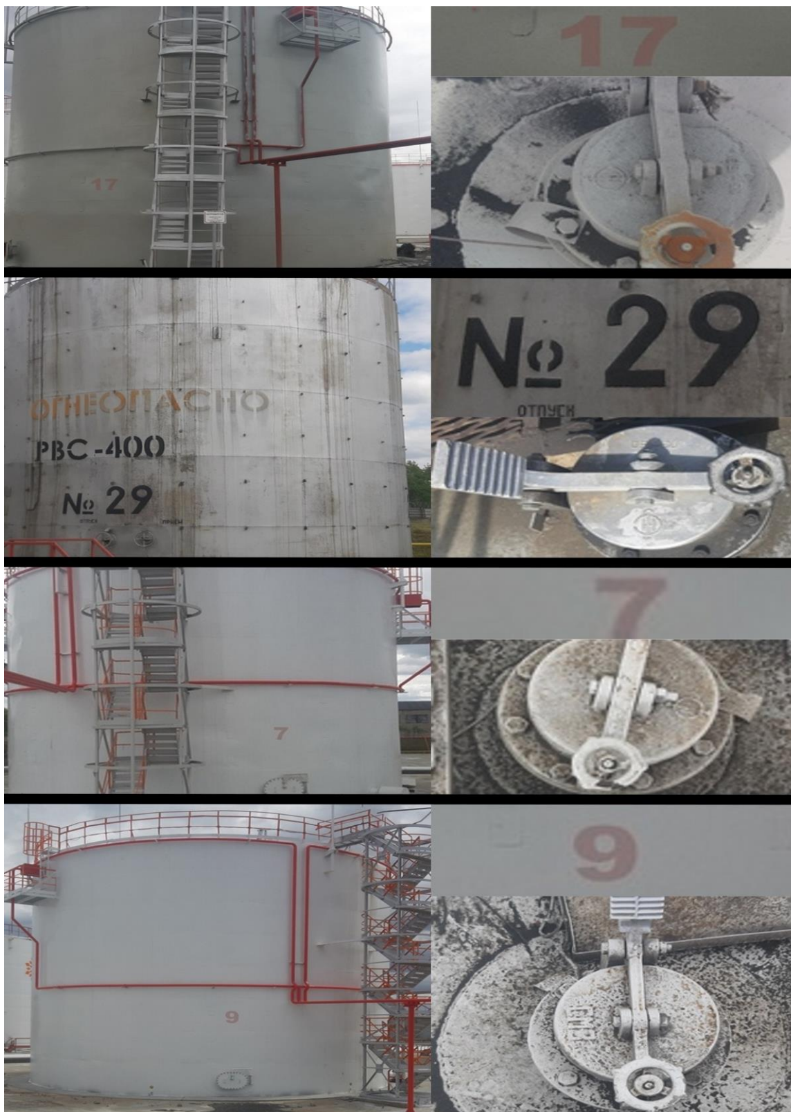
Рисунок 1 – Фотографии общего вида резервуаров стальных вертикальных цилиндрических PBC-400(№29), PBC-1000(№7), PBC-2000(№№9, 17), горловин замерных люков и заводских номеров
