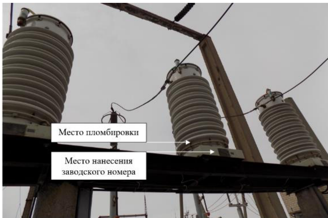
Рисунок 1 – Общий вид средства измерений с указанием места пломбировки, места нанесения заводского номера
