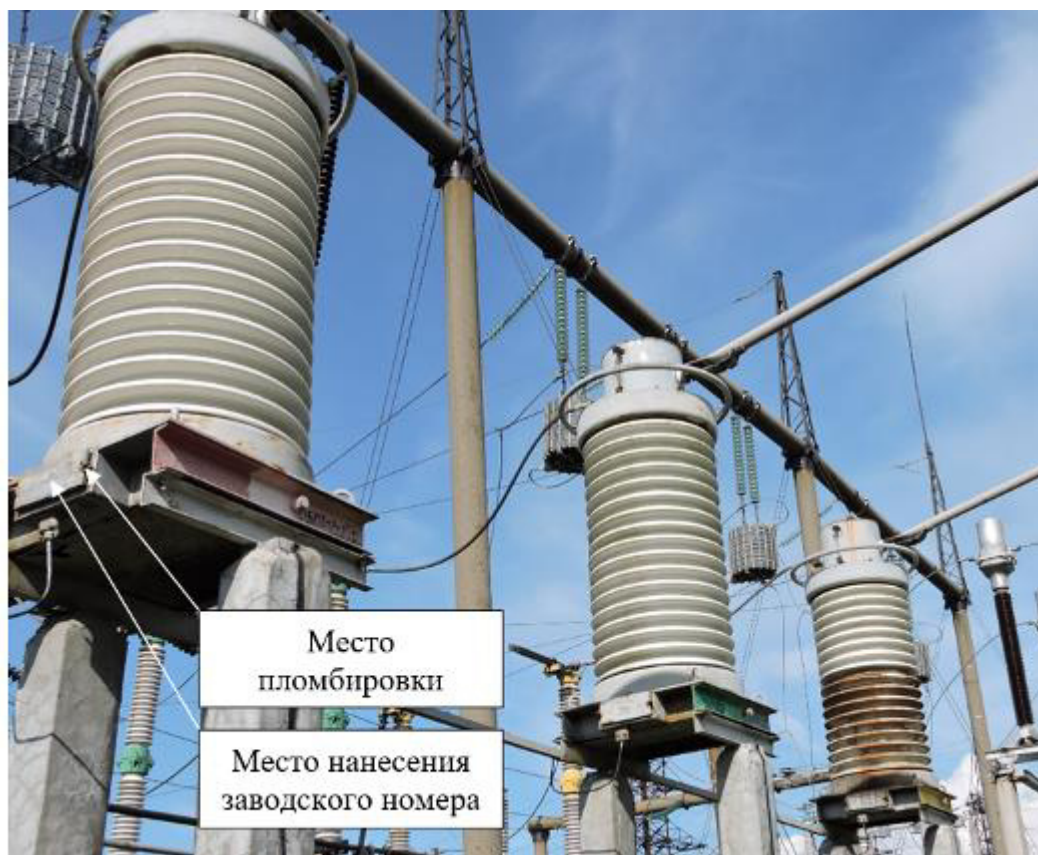
Рисунок 1 – Общий вид средства измерений с указанием места пломбировки, места нанесения заводского номера
