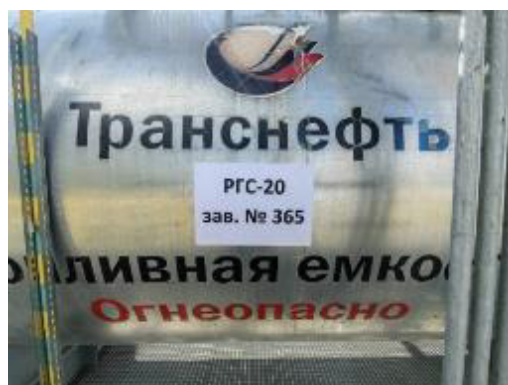
Рисунок 2 – Место нанесения заводского номера резервуара РГС-20
