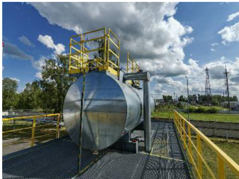
Рисунок 1 – Общий вид резервуара РГС-20
