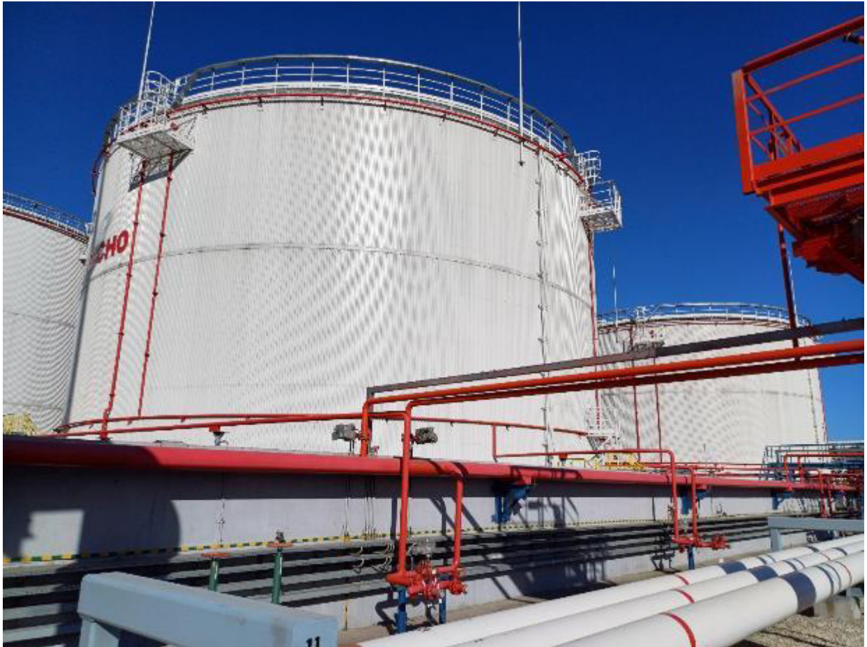
Рисунок 1 – Общий вид резервуара вертикального стального цилиндрического теплоизолированного РВС-10000
