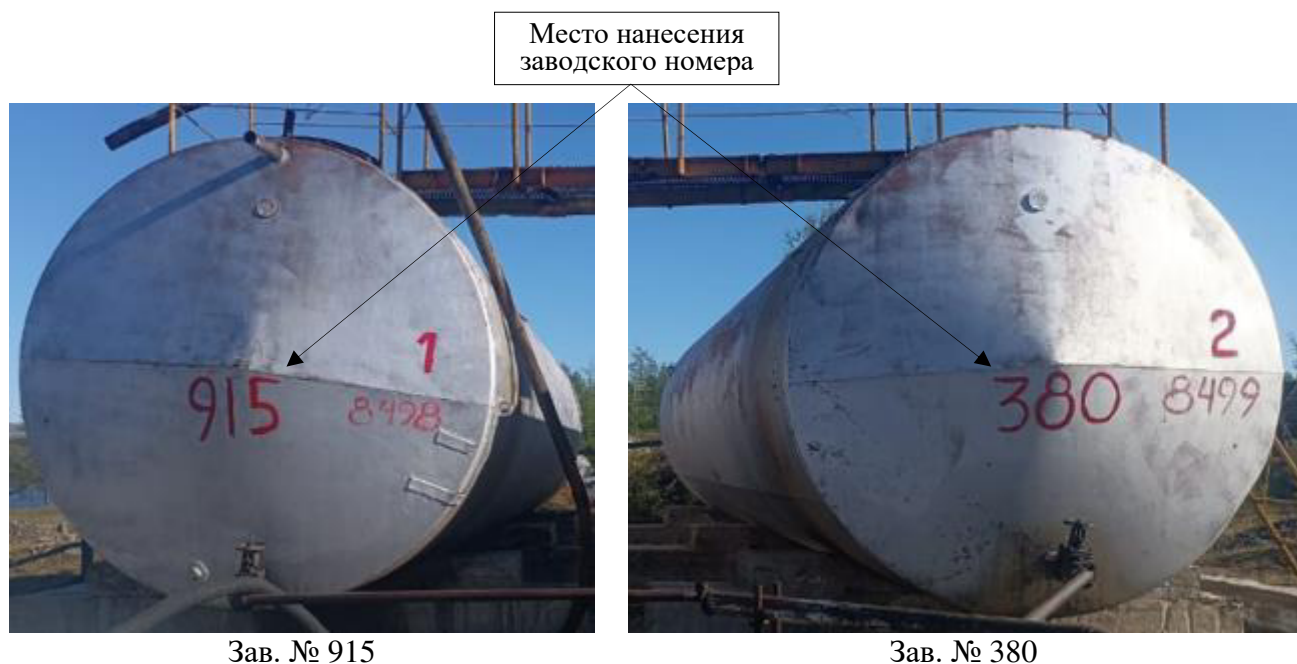
Рисунок 1 – Общий вид резервуаров
