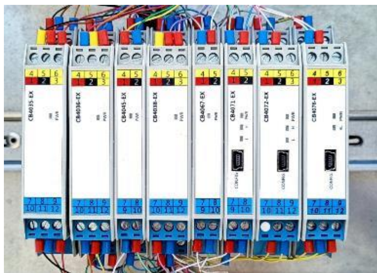
Рисунок 1 – Общий вид барьеры искробезопасные СВ
