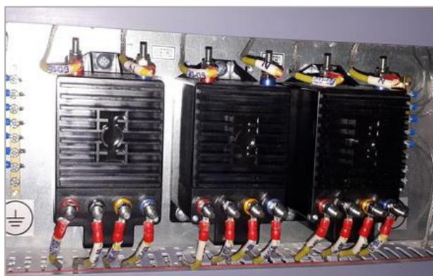
Рисунок 13 – Преобразователи напряжения первичные CV3. Вид внешний
