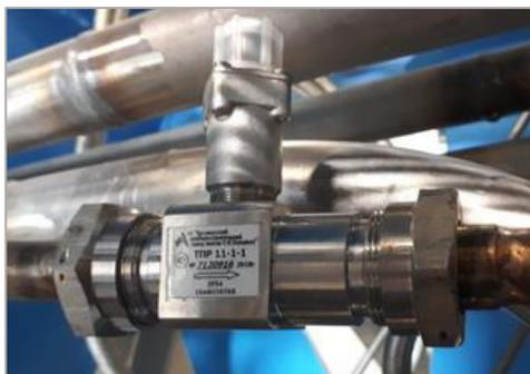
Рисунок 7 – Преобразователь расхода объемного первичный ТПР11. Вид внешний
