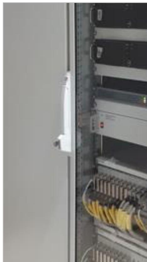
Рисунок 16 – Замок двери стойки приборной АИИС.
