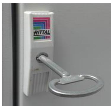
Рисунок 17 – Замок и ключ шкафа кроссового. Вид внешний
