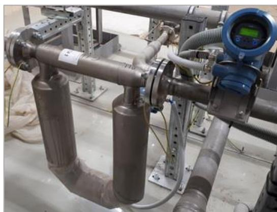
Рисунок 6 – Преобразователь расхода массового СМФ-200. Вид внешний
