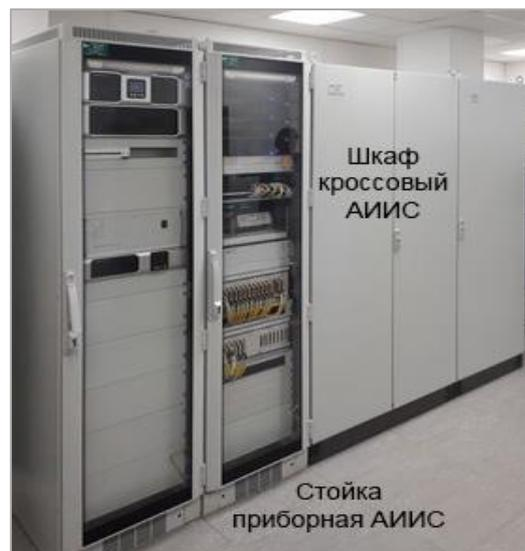
Рисунок 2 – Стойки и шкафы АИИС.
