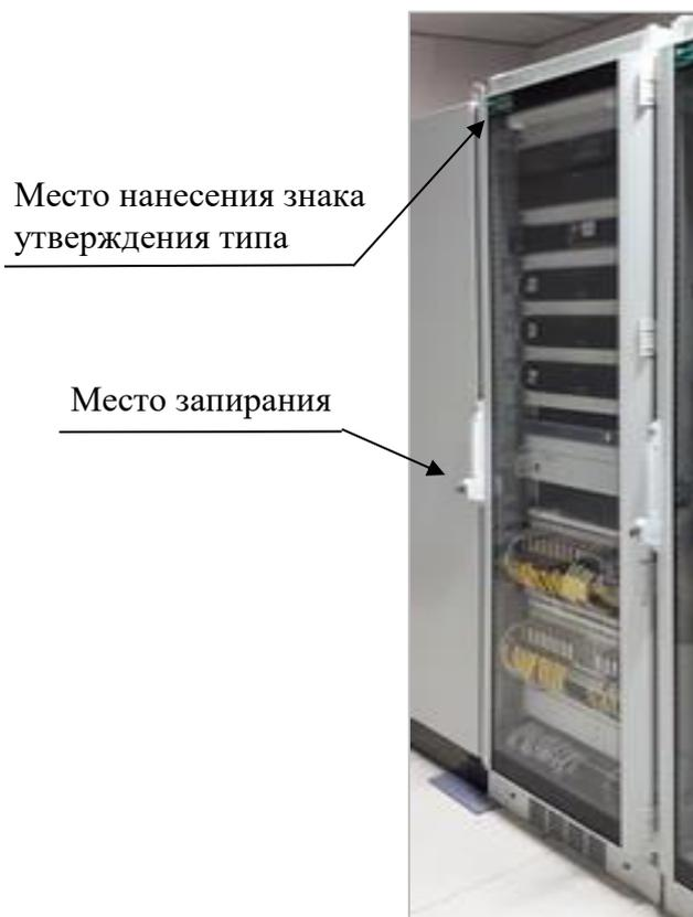
Рисунок 15 – Места расположения наклеек и запирания стойки приборной АИИС
