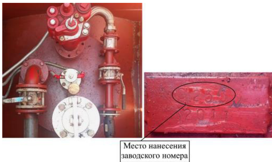
Рисунок 2 – Горловина и измерительный люк резервуара РГП 25-1-2(0,85)-О-У зав.№ 0253
