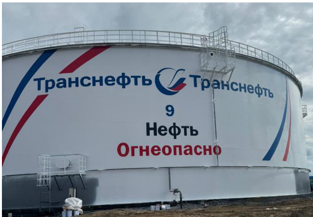
Рисунок 1 – Общий вид резервуара РВСП-20000 зав.№ 9
