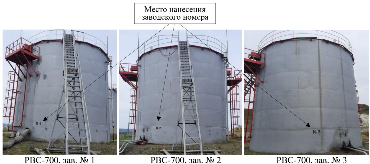
Рисунок 1 – Общий вид резервуаров, зав. № 1, 2, 3
