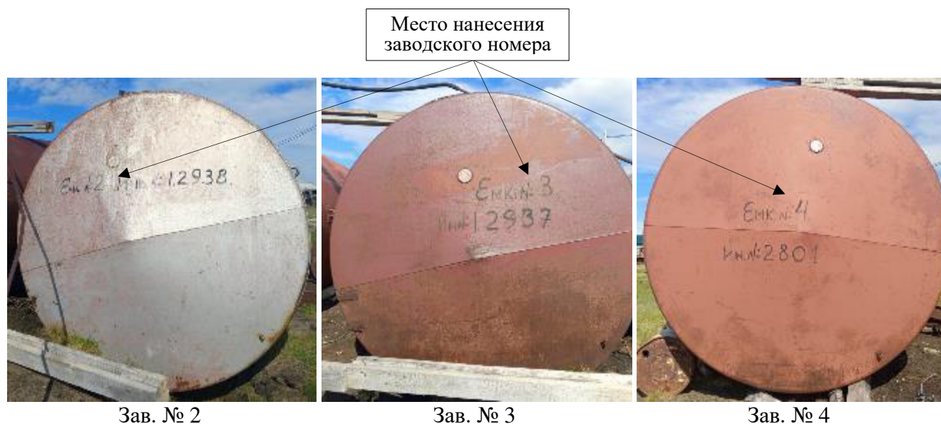
Рисунок 1 – Общий вид резервуаров
