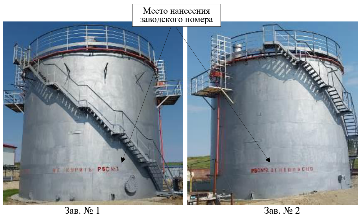
Рисунок 1 – Общий вид резервуаров
