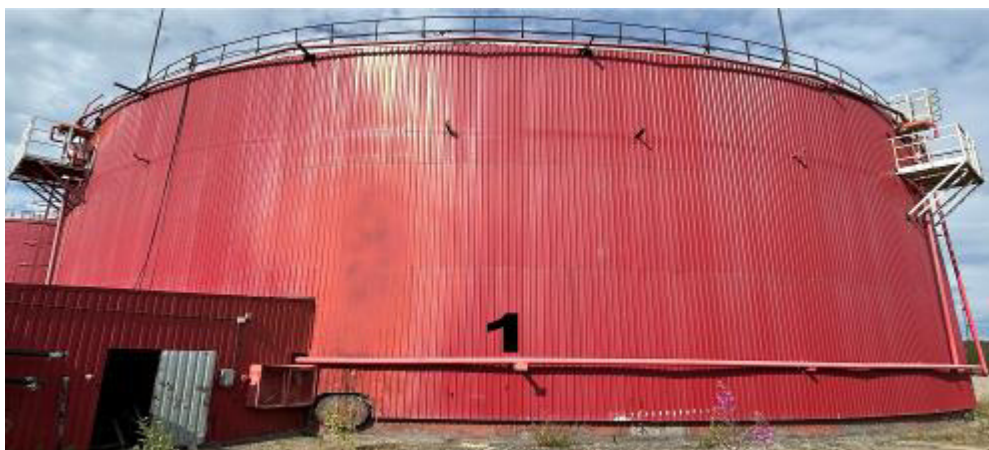
Рисунок 1 – Общий вид резервуара РВС-10000 зав. № 1
