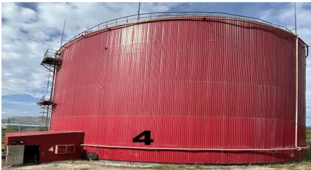
Рисунок 2 – Общий вид резервуара РВС-10000 зав. № 4
