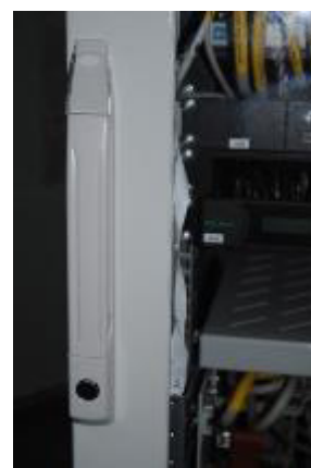
Рисунок 10 – Запирающий механизм
