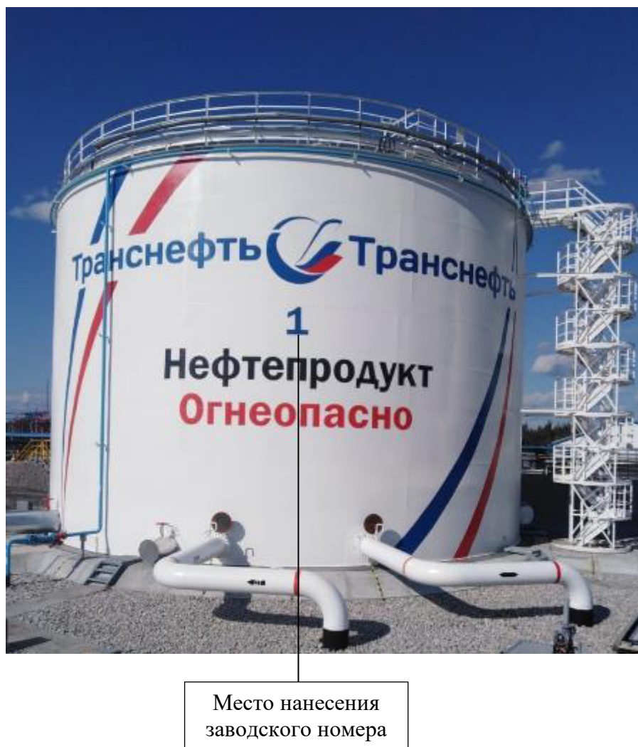
Рисунок 1 – Фотография общего вида резервуара вертикального стального цилиндрического РВС-3000, заводской номер 1
