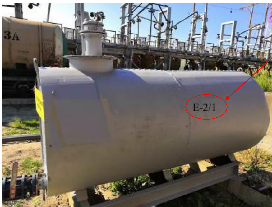
Рисунок 1 – Общий вид резервуара и замерного люка резервуара РГС-3 зав.№ E-2/1
