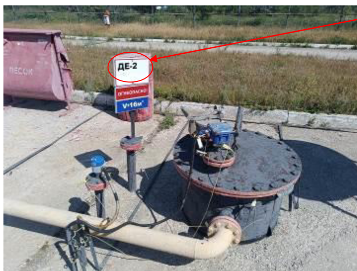
Рисунок 2 – Общий вид резервуара, заливной горловины и замерного люка РГС-16 зав.№ ДЕ-2
