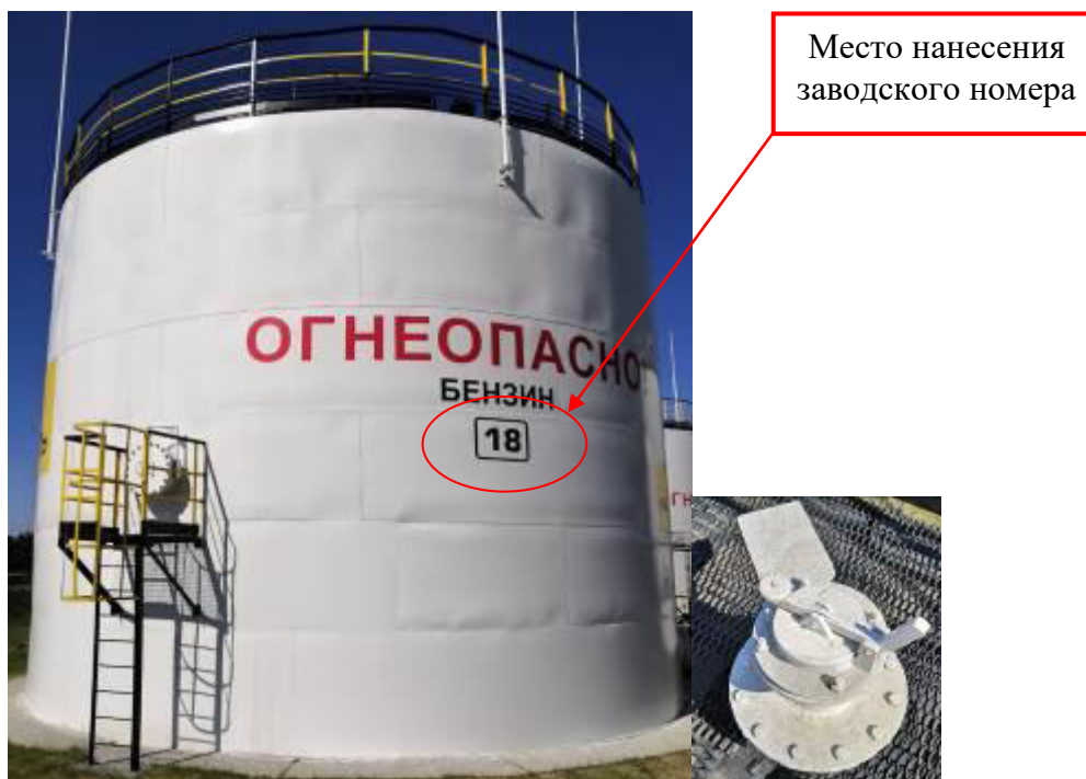
Рисунок 1 – Общий вид резервуара и замерного люка РВСП-1000 зав.№ 18
