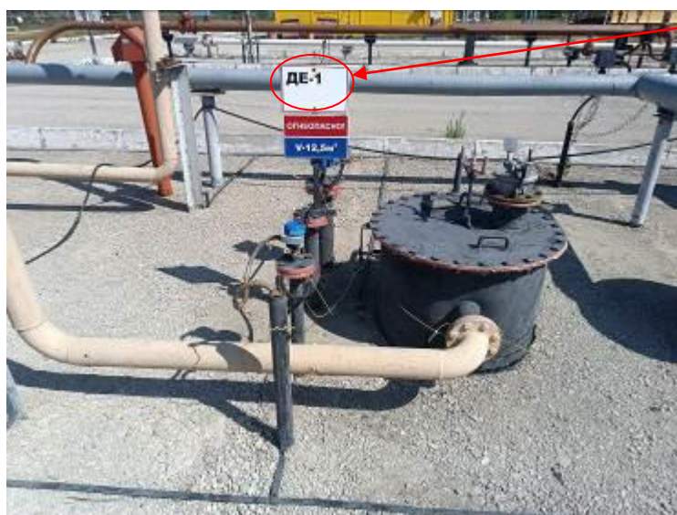
Рисунок 2 – Общий вид резервуара, заливной горловины и замерного люка РГС-12,5 зав.№ ДЕ-1
