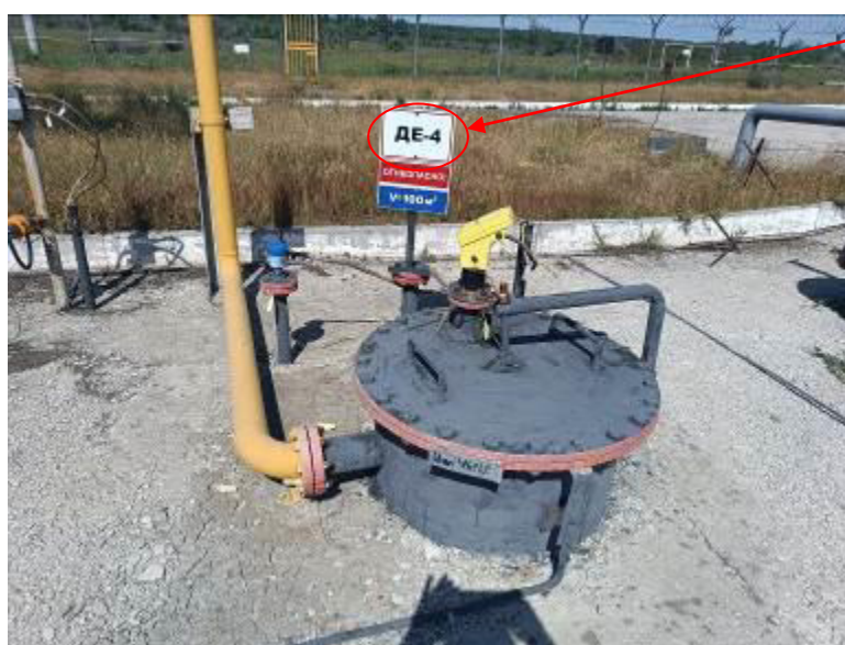
Рисунок 2 – Общий вид резервуара, заливной горловины и замерного люка РГС-100 зав.№ ДЕ-4
