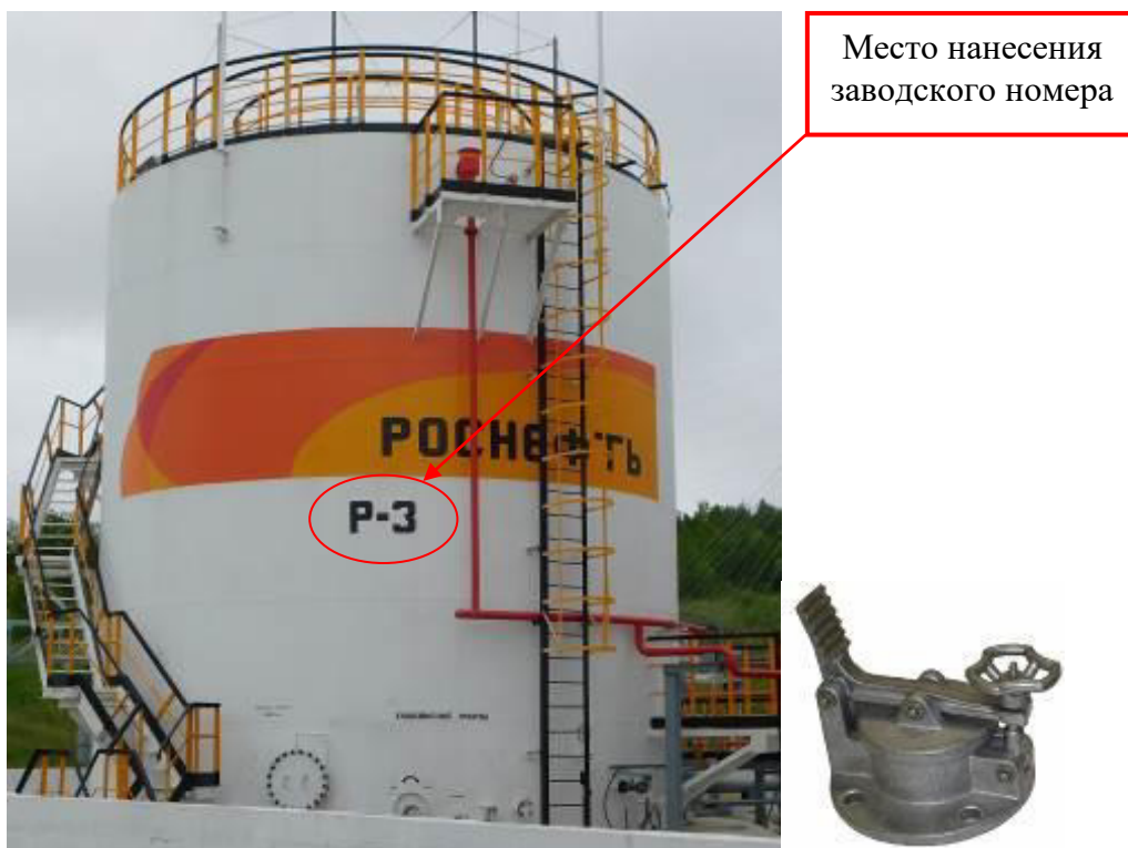
Рисунок 3 – Общий вид резервуара и замерного люка РВСП-500 зав. № Р-3
