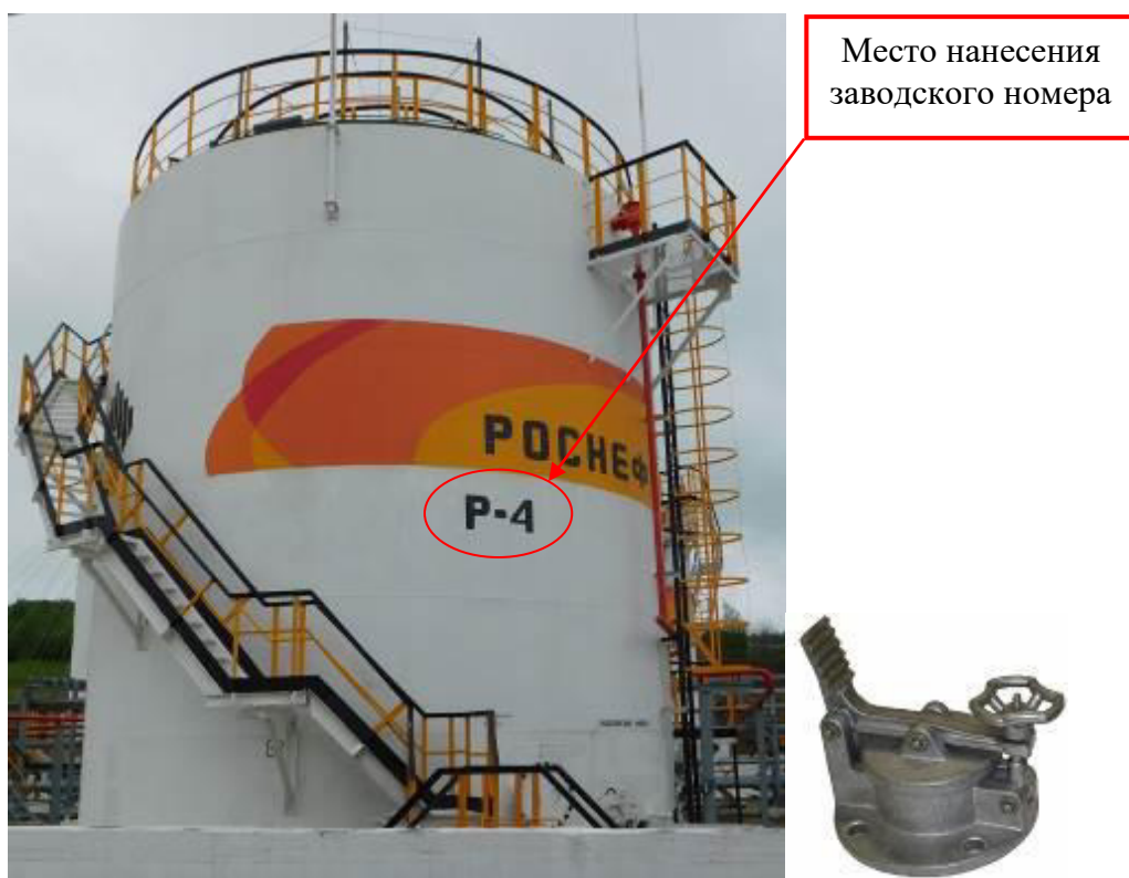
Рисунок 4 – Общий вид резервуара и замерного люка РВСП-500 зав. № Р-4
