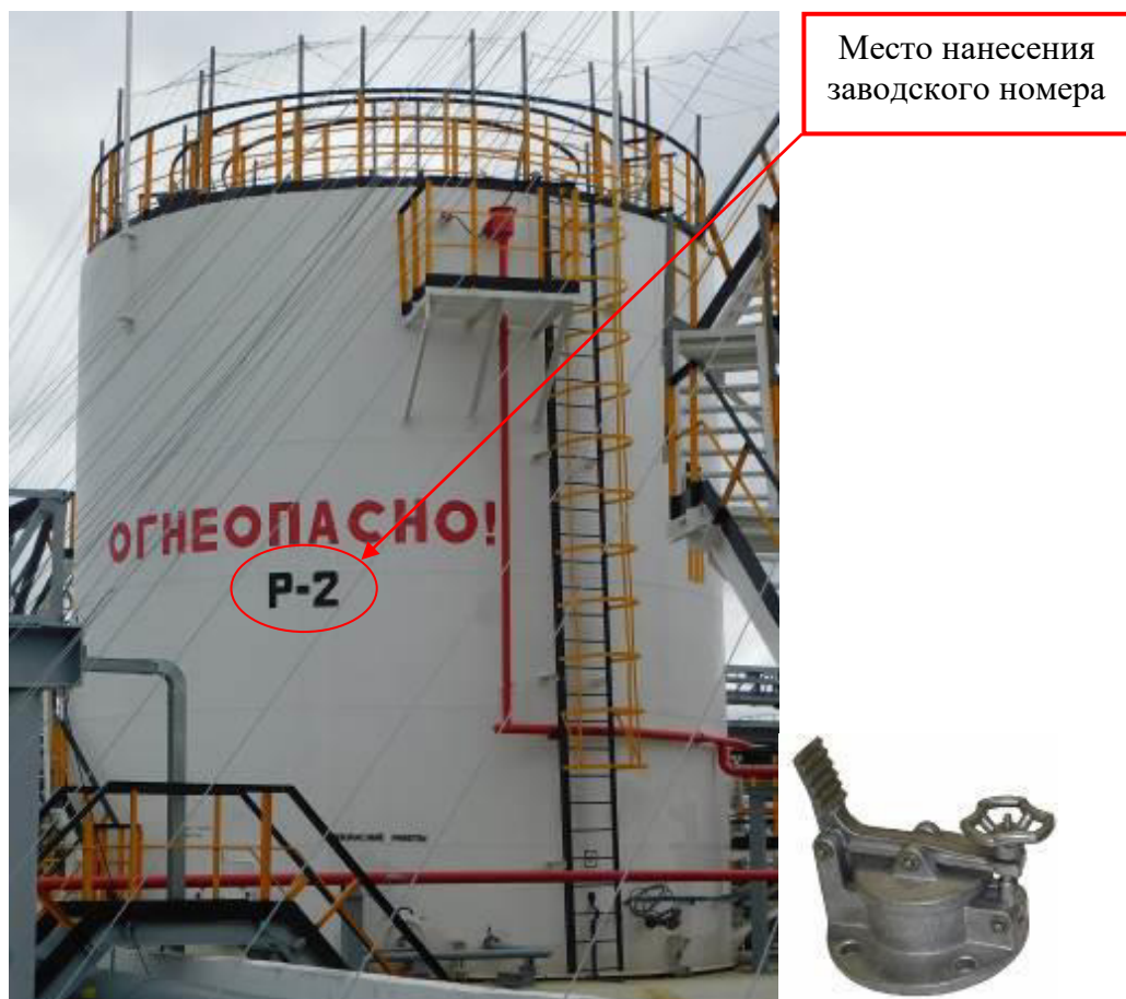
Рисунок 2 – Общий вид резервуара и замерного люка РВСП-500 зав. № Р-2
