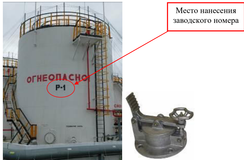
Рисунок 1 – Общий вид резервуара и замерного люка РВСП-500 зав. № Р-1
