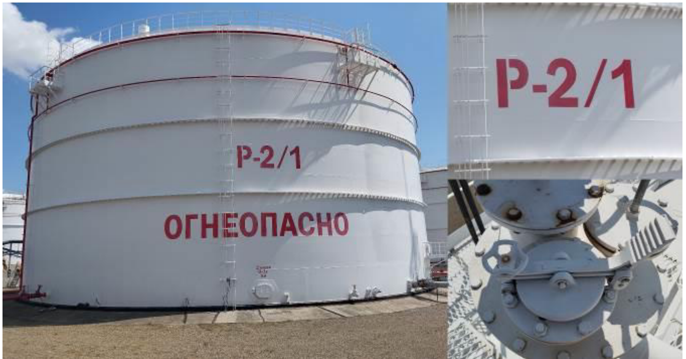
Рисунок 1 – Общий вид резервуара № P-2/1, место нанесения заводского номера, замерного люка
