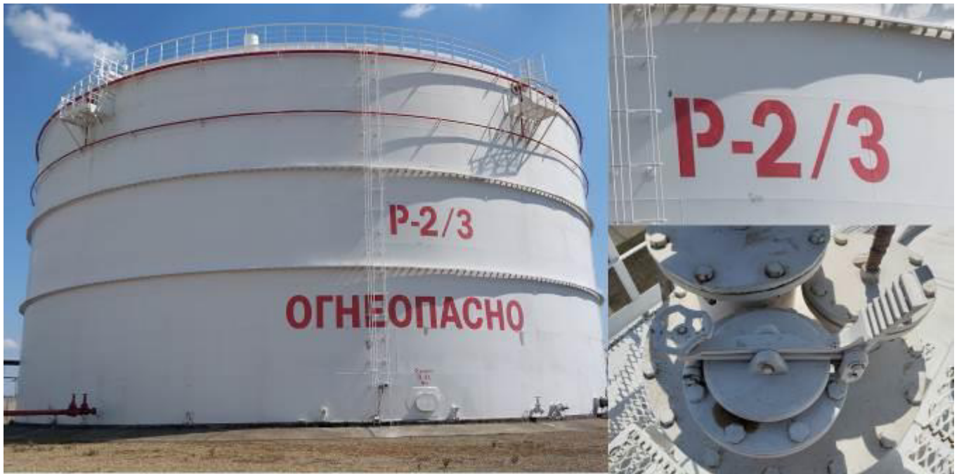
Рисунок 3 – Общий вид резервуара № P-2/3, место нанесения заводского номера, замерного люка
