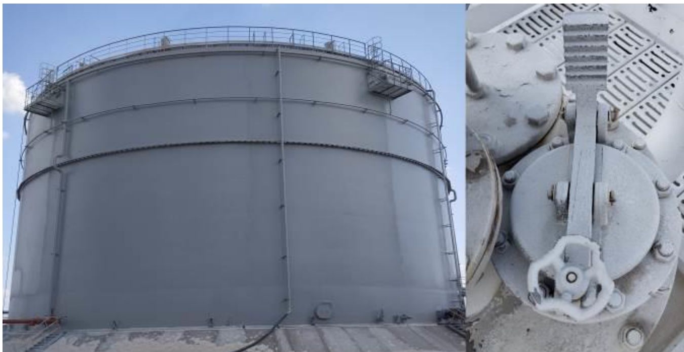
Рисунок 5 – Общий вид резервуара № P-2/5, замерного люка
