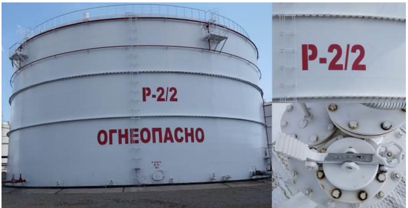
Рисунок 2 – Общий вид резервуара № P-2/2, место нанесения заводского номера, замерного люка
