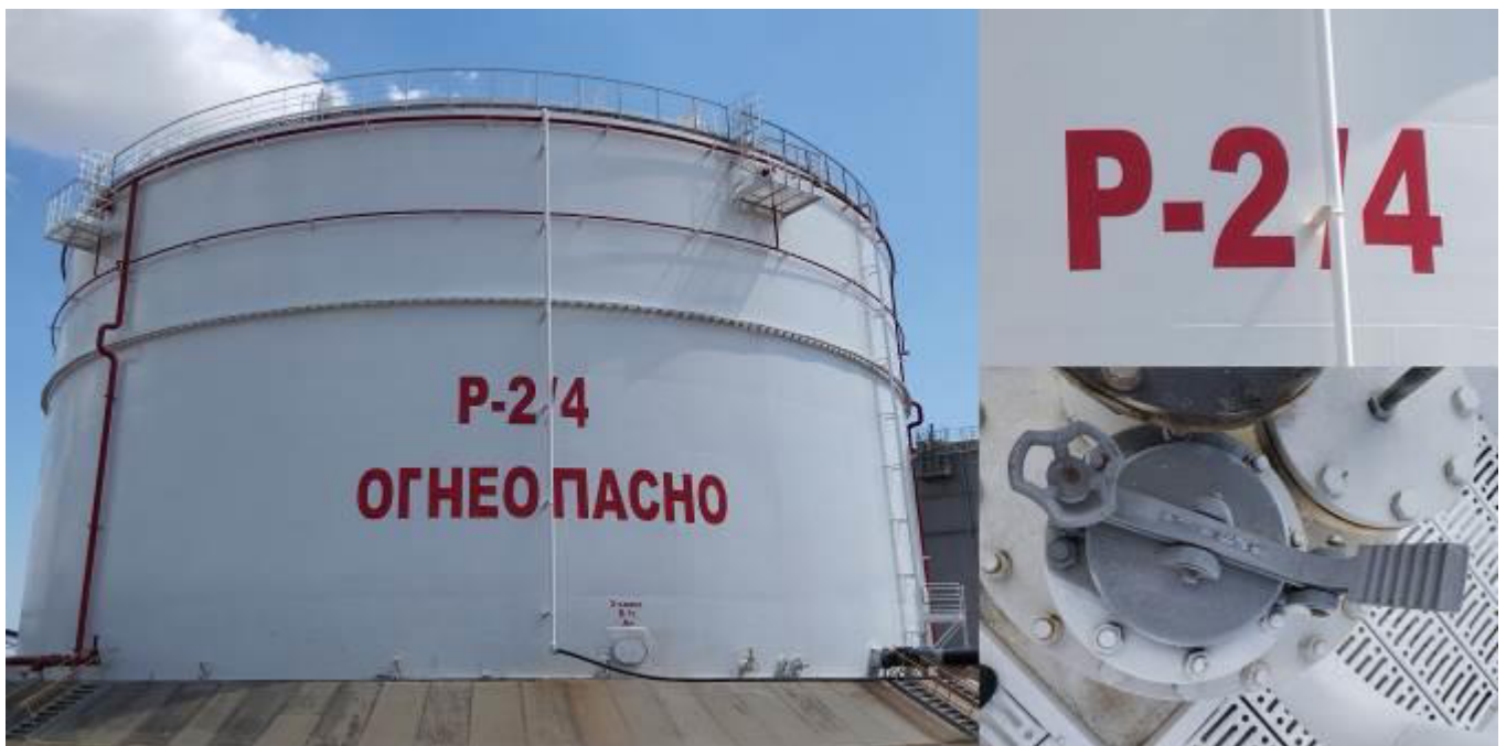
Рисунок 4 – Общий вид резервуара № P-2/4, место нанесения заводского номера, замерного люка
