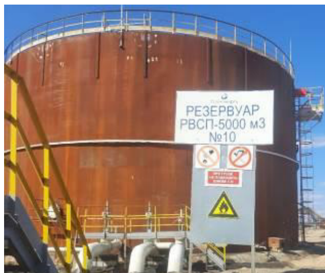
Рисунок 1 – Общий вид резервуара РВСП-5000
