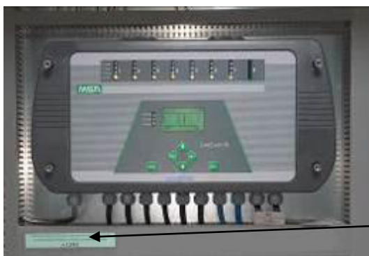
Рисунок 1 – Общий вид ЦБУ системы, зав. № 1281, места нанесения заводского номера системы
