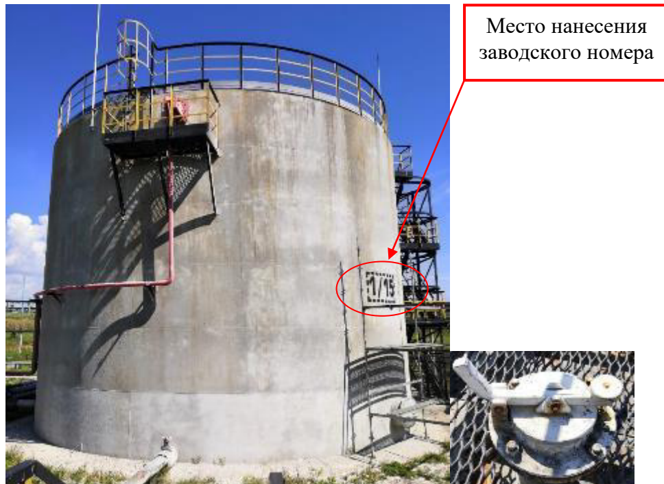
Рисунок 1 – Общий вид резервуара и замерного люка РВС-1000 зав. № 1/15
