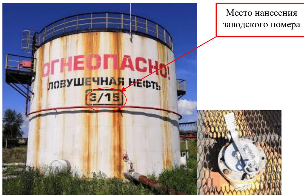
Рисунок 3 – Общий вид резервуара и замерного люка РВС-1000 зав. № 3/15
