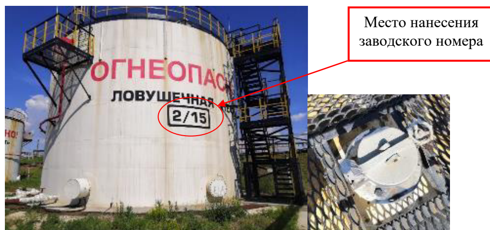
Рисунок 2 – Общий вид резервуара и замерного люка РВС-1000 зав. № 2/15
