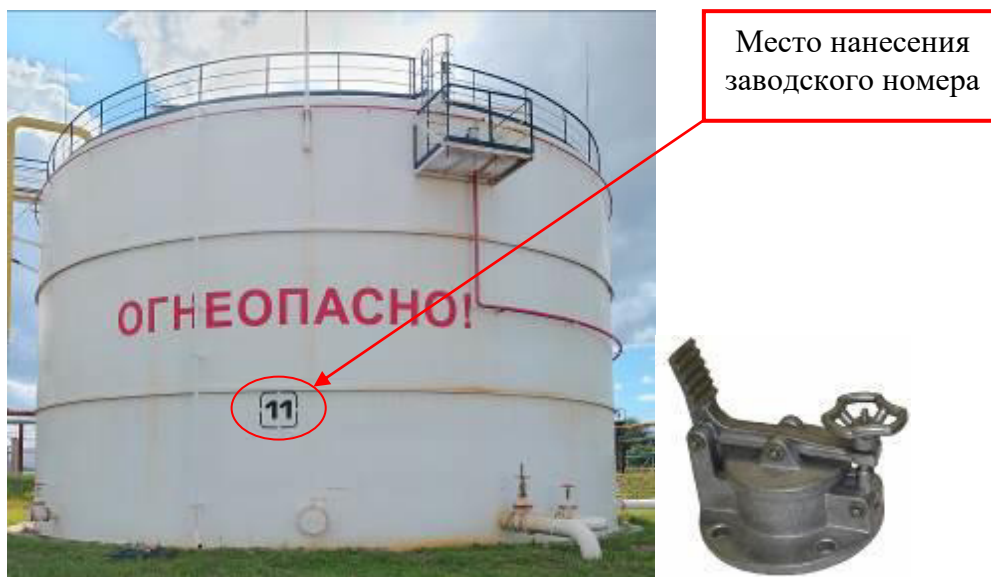
Рисунок 3 – Общий вид резервуара и замерного люка РВС-5000 зав. № 11
