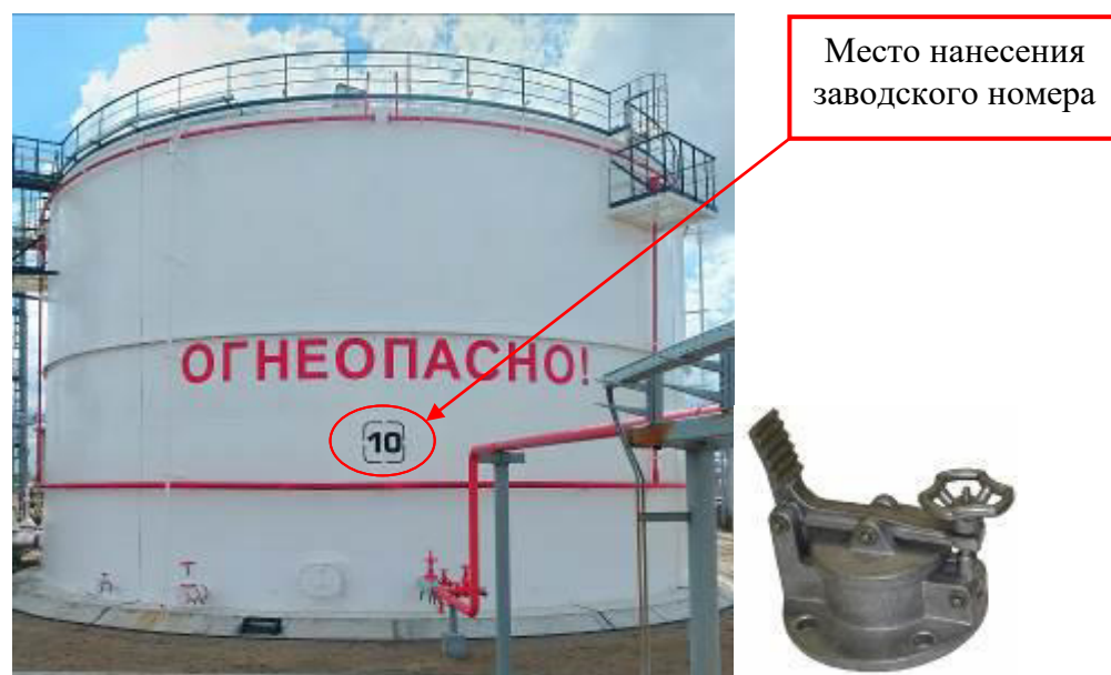
Рисунок 2 – Общий вид резервуара и замерного люка РВС-5000 зав. № 10
