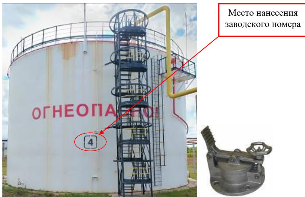
Рисунок 1 – Общий вид резервуара и замерного люка РВС-5000 зав. № 4
