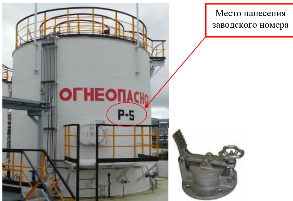
Рисунок 1 – Общий вид резервуара и замерного люка РВСП-200 зав. № P-5
