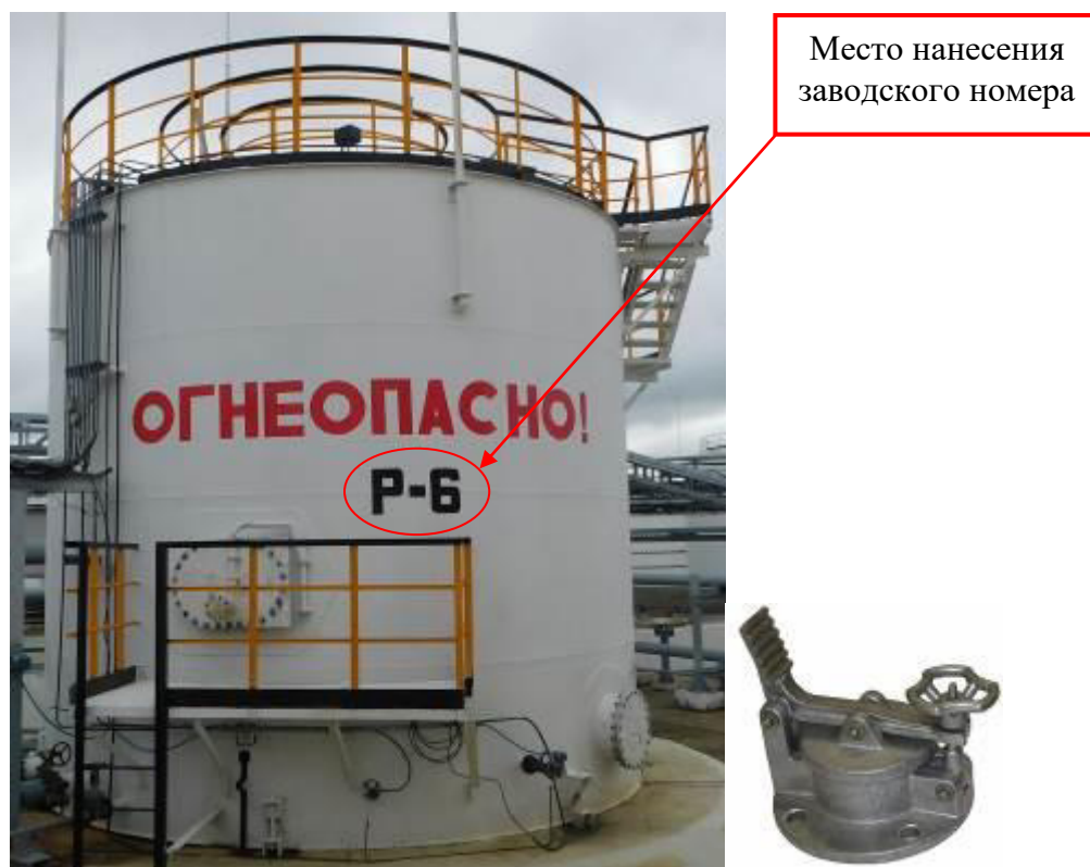
Рисунок 2 – Общий вид резервуара и замерного люка РВСП-200 зав. № P-6
