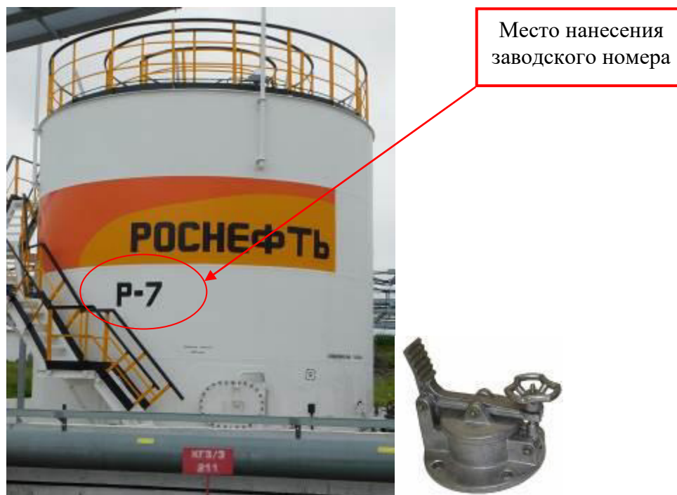
Рисунок 1 – Общий вид резервуара и замерного люка РВС-200 зав.№ P-7
