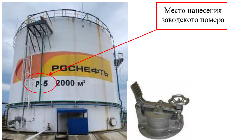
Рисунок 3 – Общий вид резервуара и замерного люка РВС-2000 зав. № Р-5
