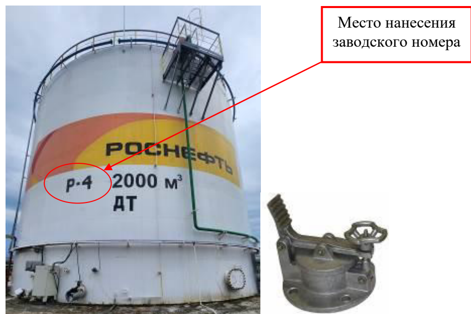
Рисунок 2 – Общий вид резервуара и замерного люка РВС-2000 зав. № Р-4
