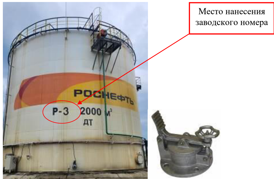
Рисунок 1 – Общий вид резервуара и замерного люка РВС-2000 зав. № Р-3
