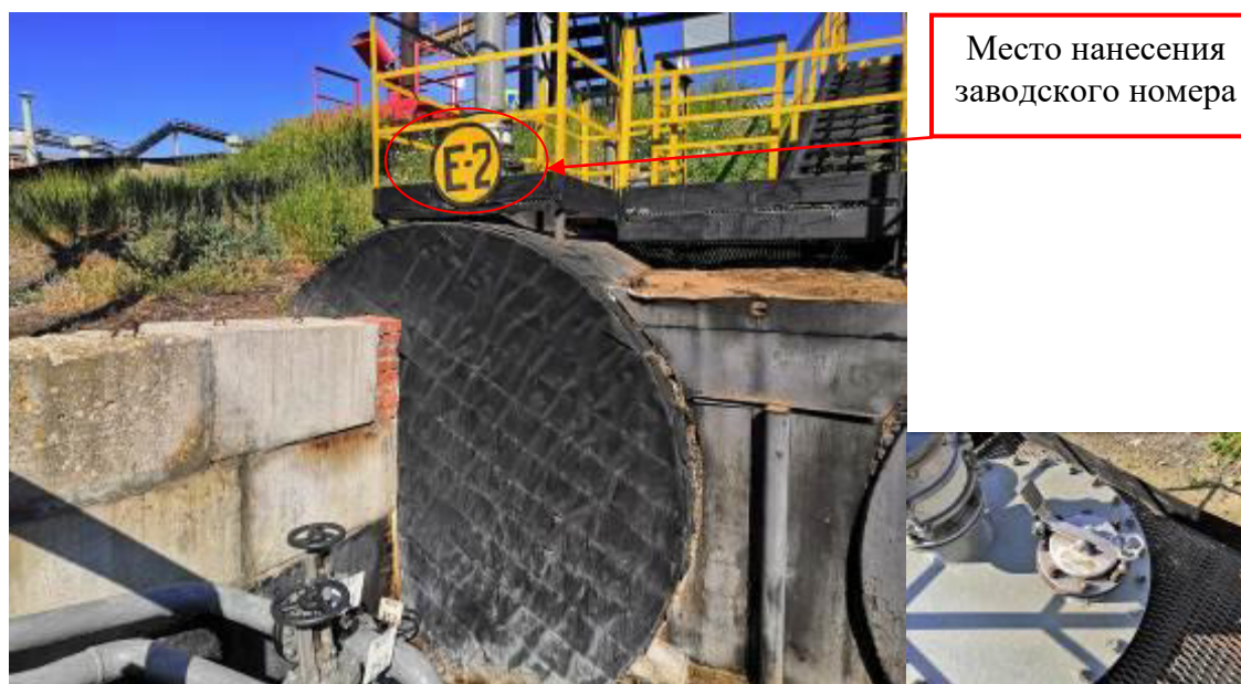
Рисунок 2 – Общий вид резервуара и замерного люка РГС-30 зав. № Е-2
