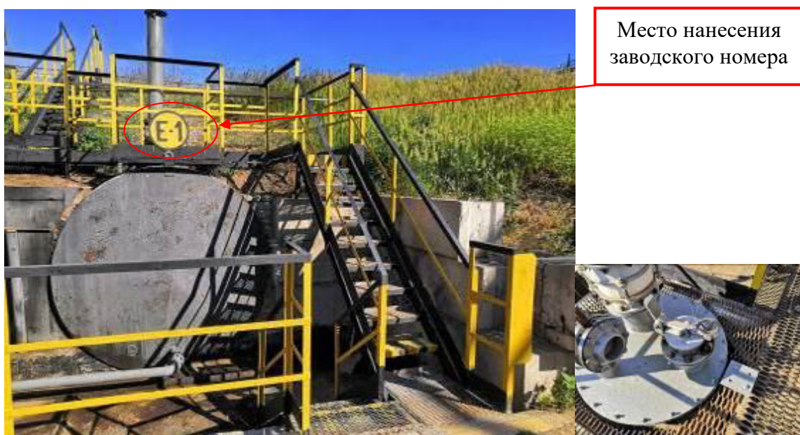
Рисунок 1 – Общий вид резервуара и замерного люка РГС-30 зав. № Е-1
