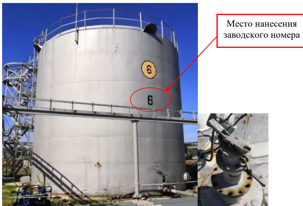
Рисунок 1 – Общий вид резервуара и замерного люка РВСП-700 зав. № 6
