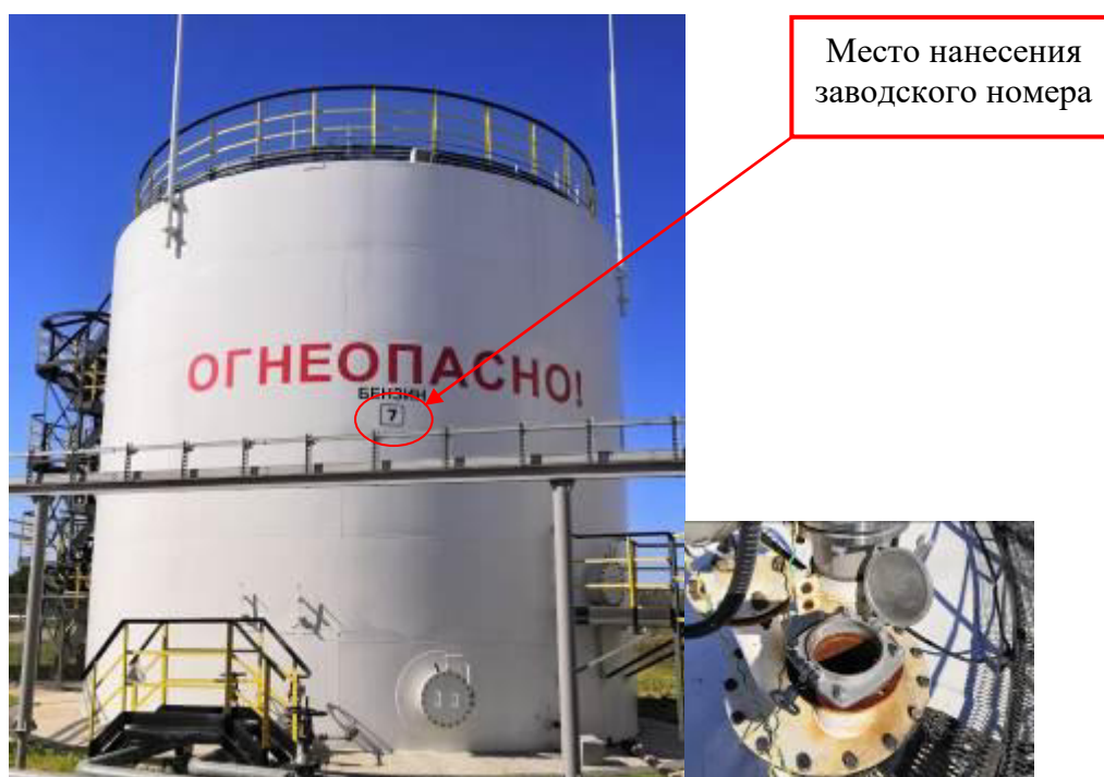
Рисунок 2 – Общий вид резервуара и замерного люка РВСП-700 зав. № 7
