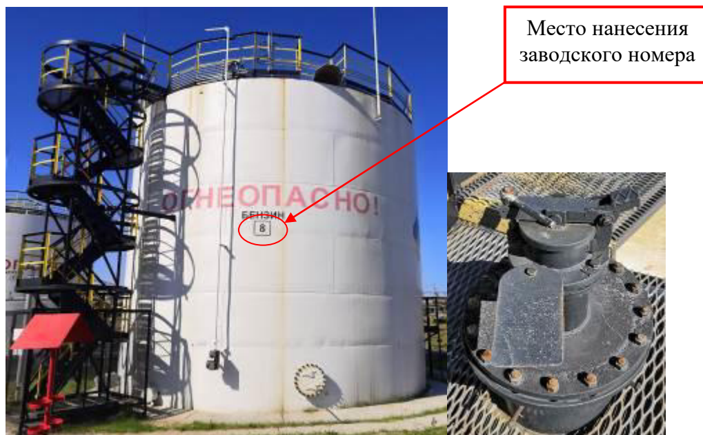
Рисунок 3 – Общий вид резервуара и замерного люка РВСП-700 зав. № 8
