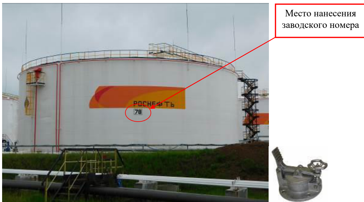
Рисунок 1 – Общий вид резервуара и замерного люка РВС-10000 зав.№ 78
