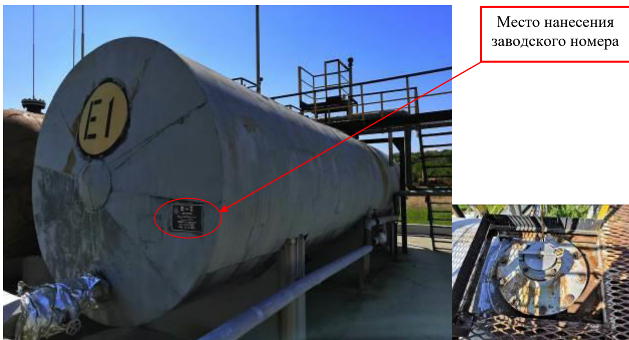
Рисунок 1 – Общий вид резервуара и замерного люка РГС-50 зав. № Е-1
