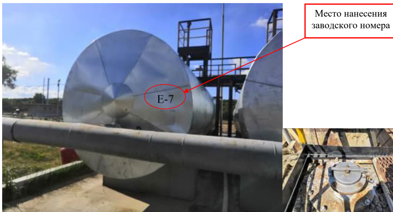
Рисунок 7 – Общий вид резервуара и замерного люка РГС-50 зав. № Е-7
