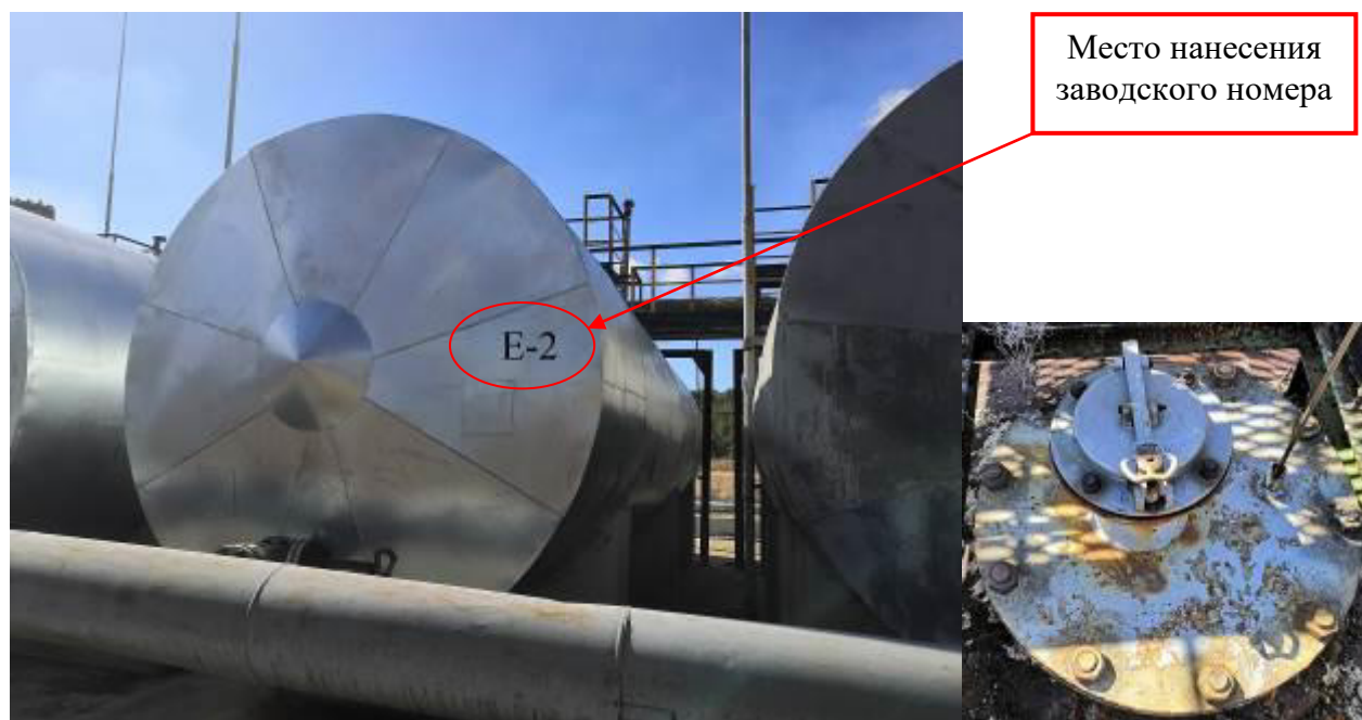
Рисунок 2 – Общий вид резервуара и замерного люка РГС-50 зав. № Е-2
