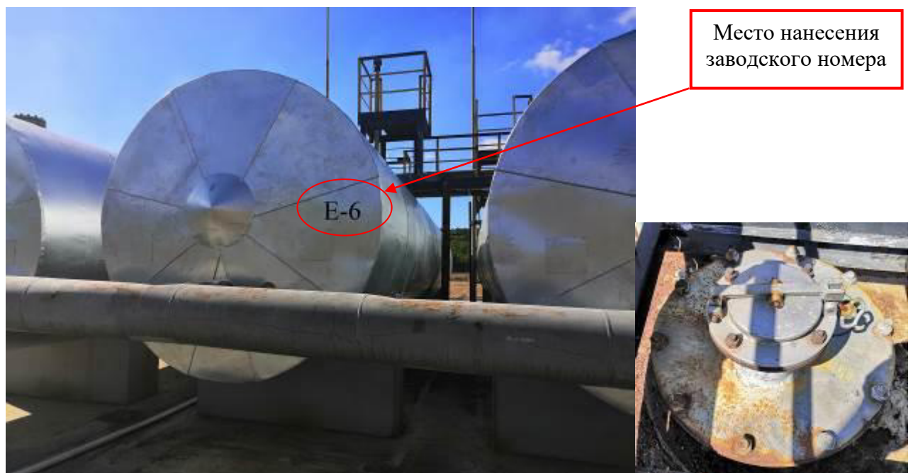
Рисунок 6 – Общий вид резервуара и замерного люка РГС-50 зав. № E-6
