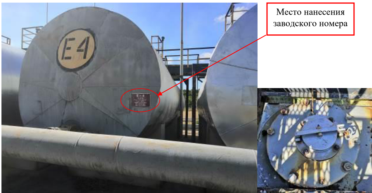
Рисунок 4 – Общий вид резервуара и замерного люка РГС-50 зав. № Е-4
