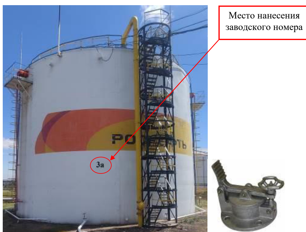
Рисунок 2 – Общий вид резервуара и замерного люка РВС-5000 зав. № 3а
