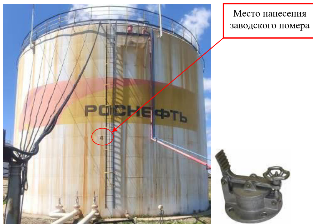
Рисунок 3 – Общий вид резервуара и замерного люка РВС-5000 зав. № 4
