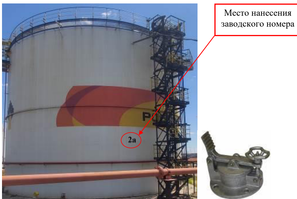
Рисунок 1 – Общий вид резервуара и замерного люка РВС-5000 зав. № 2а
