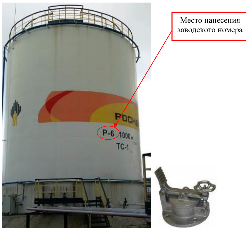
Рисунок 3 – Общий вид резервуара и замерного люка РВС-1000 зав. № Р-6
