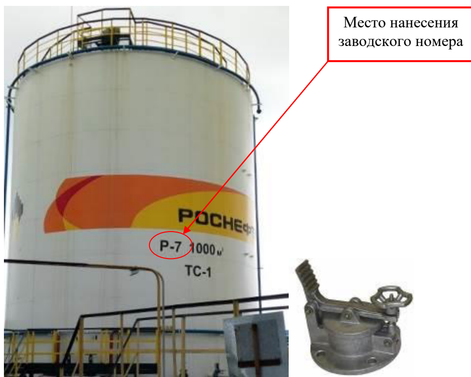
Рисунок 4 – Общий вид резервуара и замерного люка РВС-1000 зав. № Р-7
