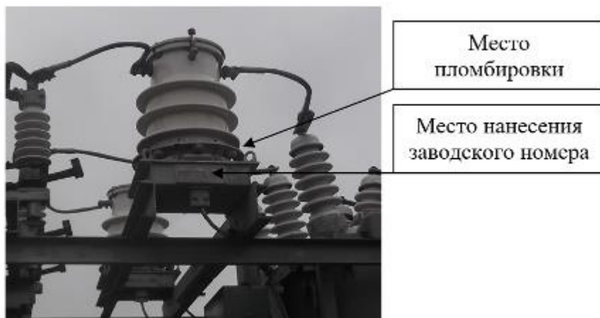
Рисунок 1 – Общий вид средства измерений с указанием места пломбировки, места нанесения заводского номера
