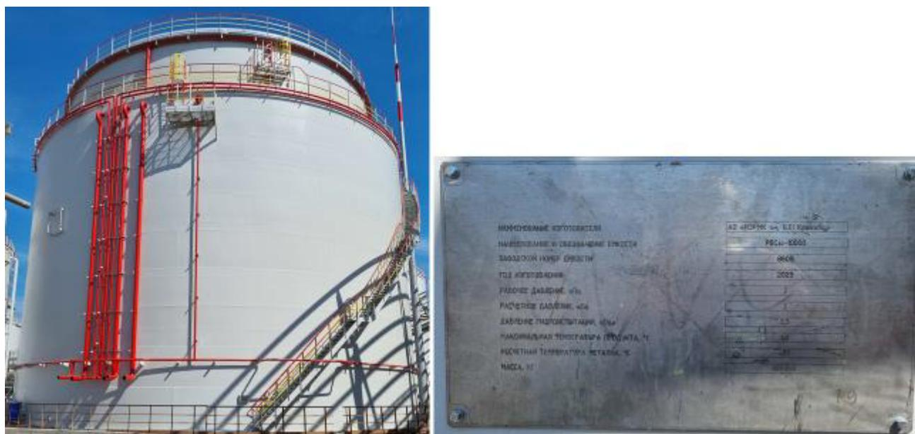
Рисунок 3 – Общий вид маркировочной таблички и резервуара РВСзс-10000 зав.№ 8609
