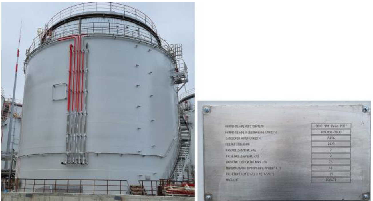
Рисунок 4 – Общий вид маркировочной таблички и резервуара РВСтзс-3000 зав.№ 8604
