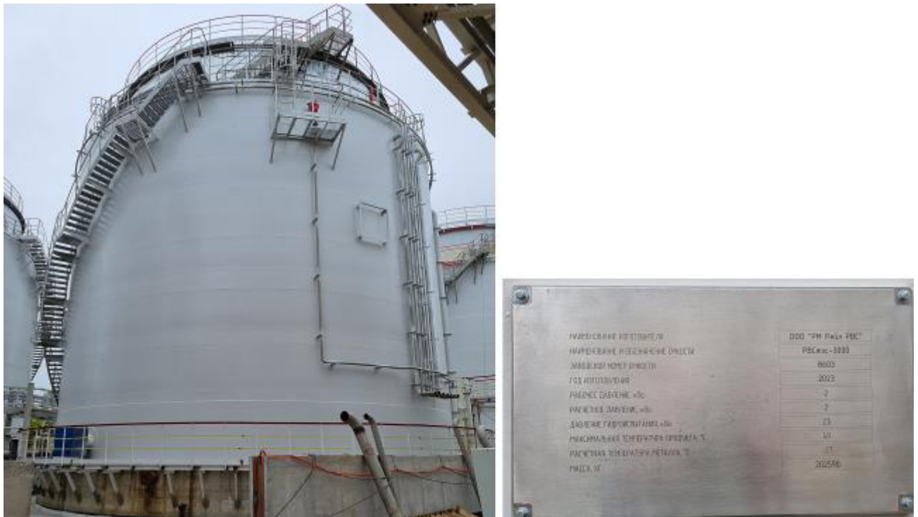
Рисунок 3 – Общий вид маркировочной таблички и резервуара РВСтзс-3000 зав.№ 8603
