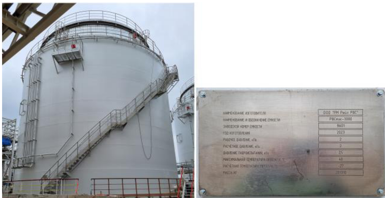
Рисунок 1 – Общий вид маркировочной таблички и резервуара РВСтзс-3000 зав.№ 8601
