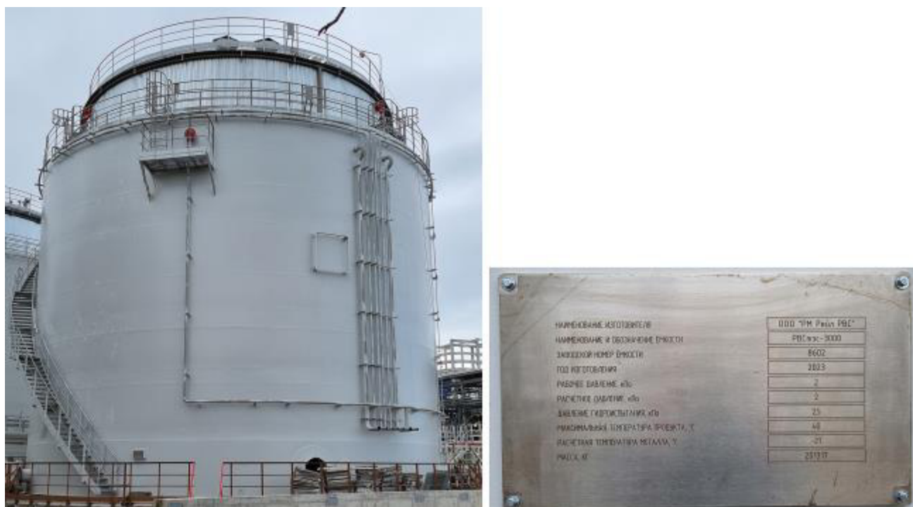
Рисунок 2 – Общий вид маркировочной таблички и резервуара РВСтзс-3000 зав.№ 8602
