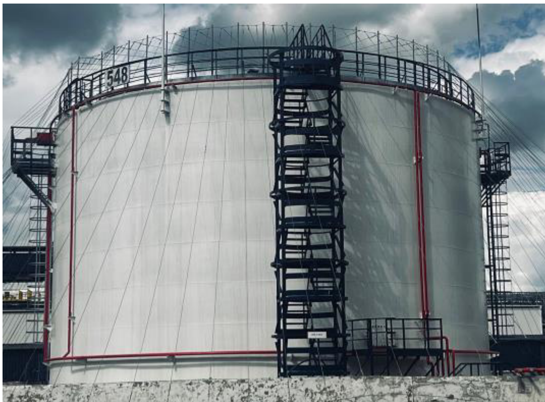
Рисунок 1 – Общий вид резервуара РВСП-3000 зав.№548
