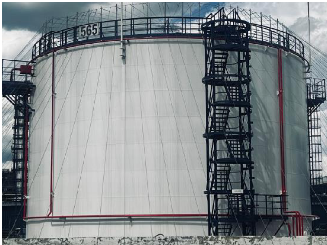
Рисунок 3 – Общий вид резервуара РВСП-3000 зав.№565
