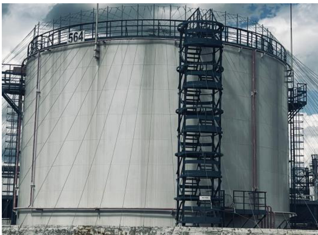
Рисунок 2 – Общий вид резервуара РВСП-3000 зав.№564
