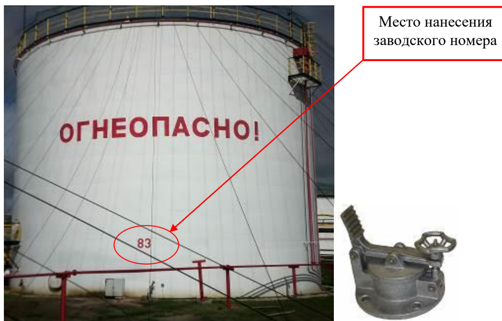
Рисунок 1 – Общий вид резервуара и замерного люка РВСП-5000 зав. № 83
