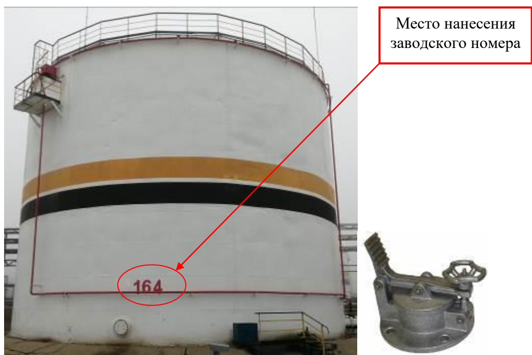
Рисунок 2 – Общий вид резервуара и замерного люка РВСП-5000 зав. № 164
