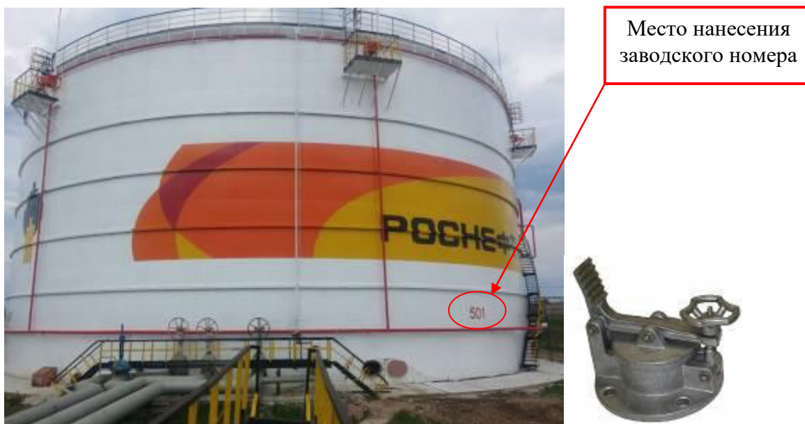
Рисунок 1 – Общий вид резервуара и замерного люка РВСП-20000 зав. № 501
