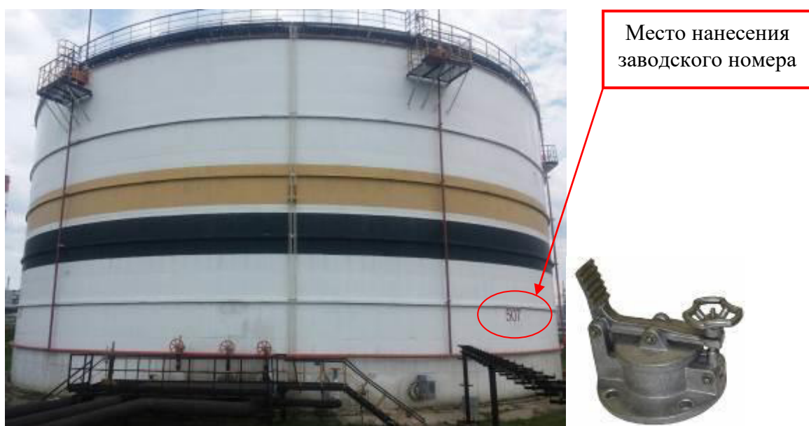
Рисунок 2 – Общий вид резервуара и замерного люка РВСП-20000 зав. № 507
